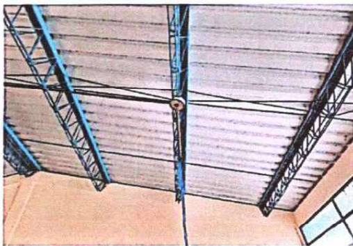
3. Deterioro de Sistema eléctrico.
