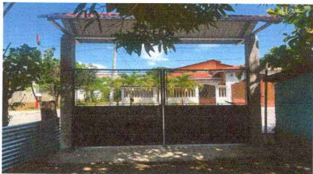
Foto 1. Sustitución de portón de metal
