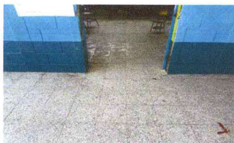
Foto 9. Cambio de piso de torta por granito
