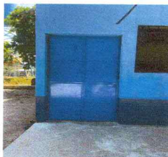
Foto 6. Sustitución de puerta
