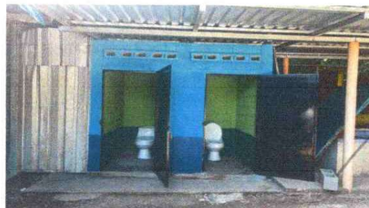
Foto 8. sustitucion de inodoro
