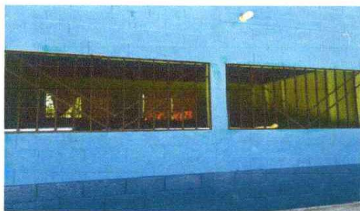
Foto 7. Pintura en muros exteriores e interiores
