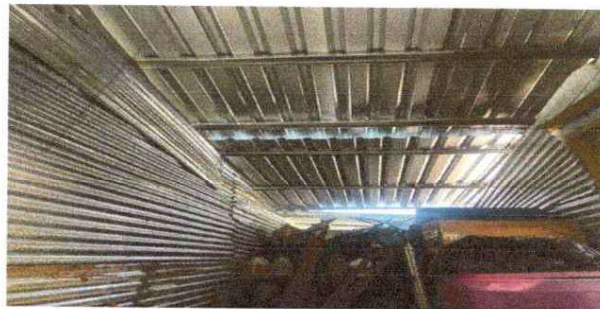
Foto 2. sustitución de lamina por lamina troquelada
