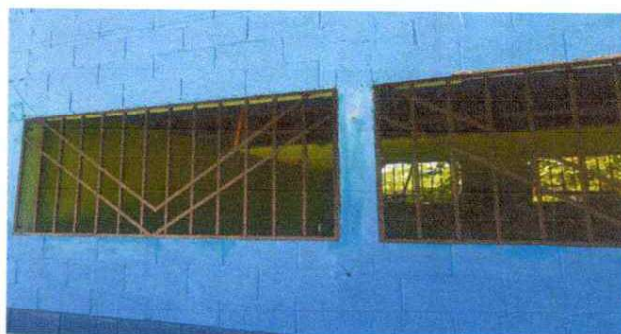
Foto 4. sustitución de Balcones de metal
