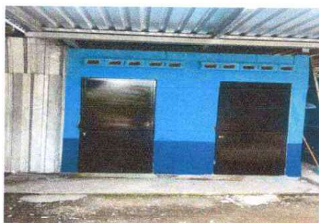
Foto3. Sustitución de puertas de servicios sanitarios
