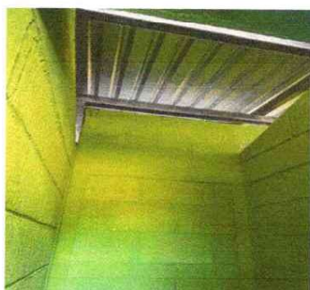
Foto 5 Sustitución de lamina por lamina troquelada y soporte de estructura de madera por metal
