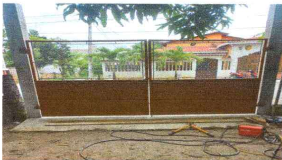
Foto 1. Sustitución de portón de metal
