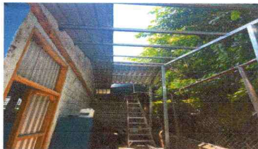
Foto 2. sustitución de lamina por lamina troquelada
