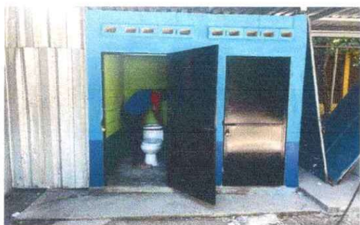
Foto3. Sustitución de puertas de servicios sanitarios
