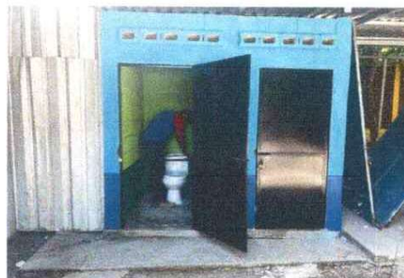
Foto 8. sustitución de inodoro
