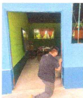
Foto 6. Sustitución de puerta
