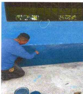
Foto 7. Pintura en muros exteriores e interiores
