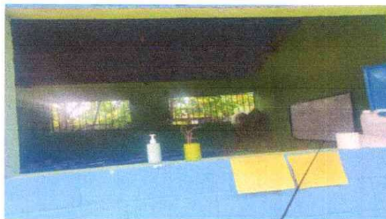
Foto 4. sustitución de Balcones de metal
