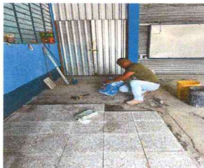
Foto 9. Cambio de piso de torta por granito
