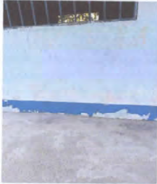
Foto 7: Pintura en muros exteriores e interiores.
