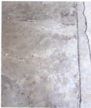
Foto 9: Cambio de piso de torta por granito
