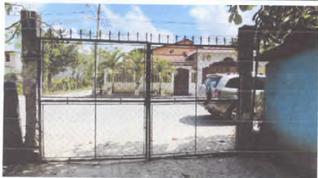
Foto 1: Sustrucion de porton de metal.
