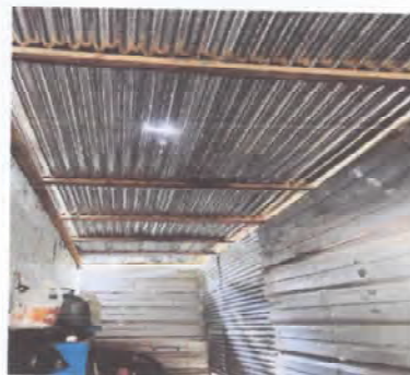
Foto 2: Sustrucion de lamina por lamina troquelada.
