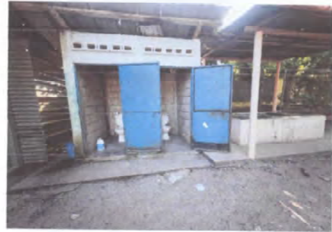
Foto 8: Sustitución de inodoros
