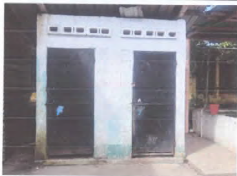
Foto 3: Sustrucion de puertas de servicio de sanitarios.
