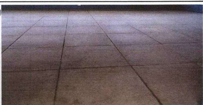
Sustitución de torta de concreto por cerámico
