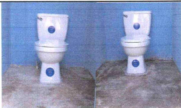
Sustitución de inodoros
