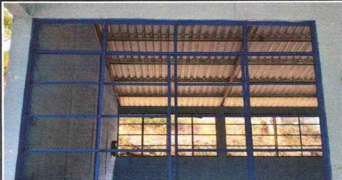
sustitución de vidrios y mantenimiento a estructura de metal
