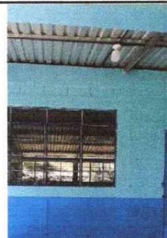
Pintura en muros exteriores e interiores
