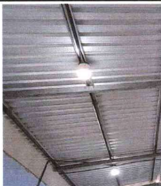
Reparación de sistema eléctrico
