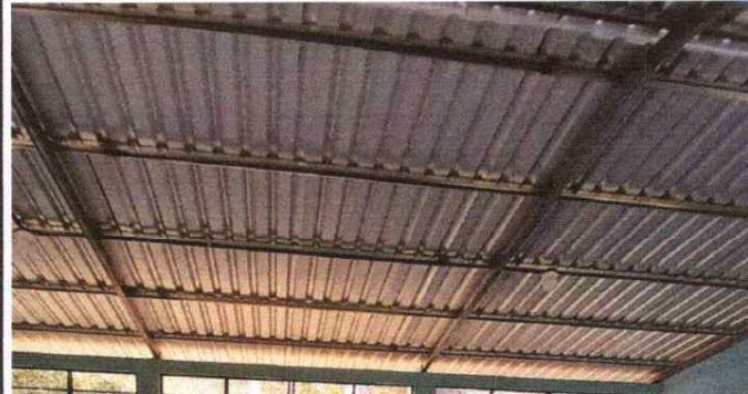
Estructura de techo de metal por metal
