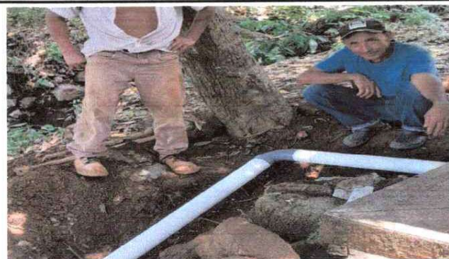
Reparación de drenaje, aguas negras
