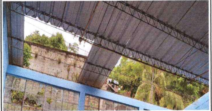
Estructura de techo de metal por metal
