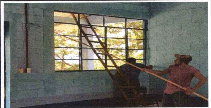
Pintura en muros exteriores e interiores
