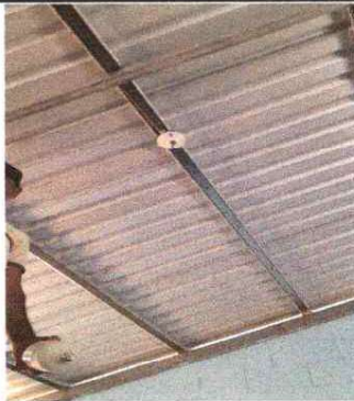
Reparación de sistema eléctrico
