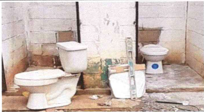
Sustitución de inodoros
