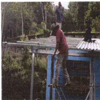
Estructura de techo de madera por metal.
