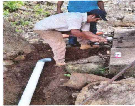
Reparación de drenaje, aguas negras
