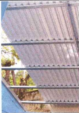
Cubierta de lámina y sustitución de lámina troquelada
