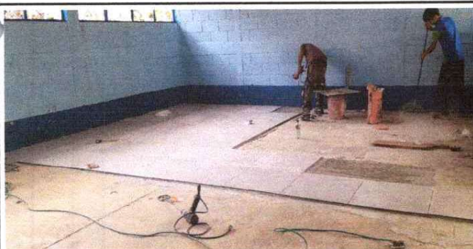
Sustitución de torta de concreto por cerámico
