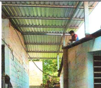
2.1 Sustitución de soporte de metal por metal
