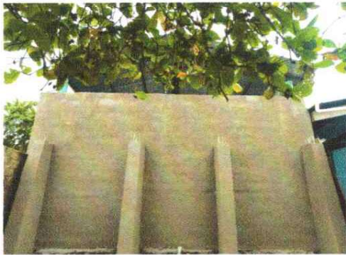
8.1 Reparación de muro
