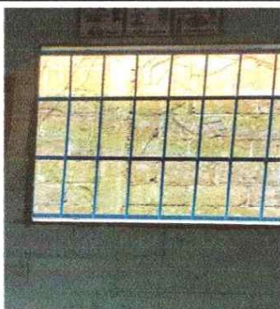
6.1 Sustitución de Balcones
