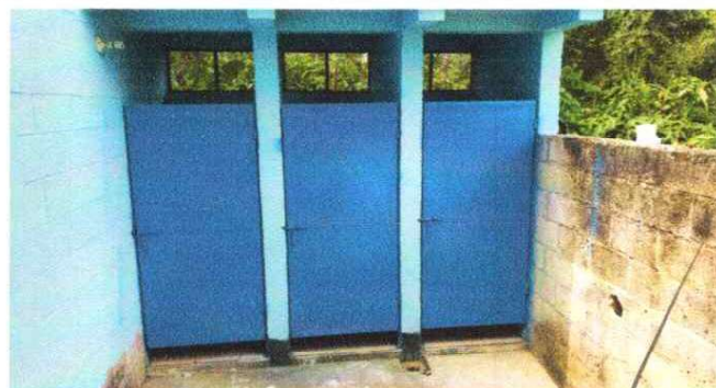
5.1 Sustitución de puerta de metal
