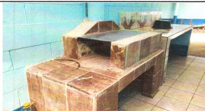
4.1 Sustitución de plancha de metal
