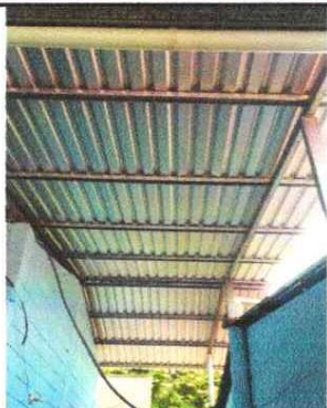
1.1 Sustitución de Lámina por lámina troquelada aluzinc 26
