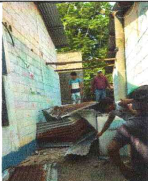
1.1 Sustitución de Lámina por lámina troquelada aluzinc 26
