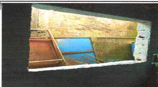
6.1 Sustitución de Balcones
