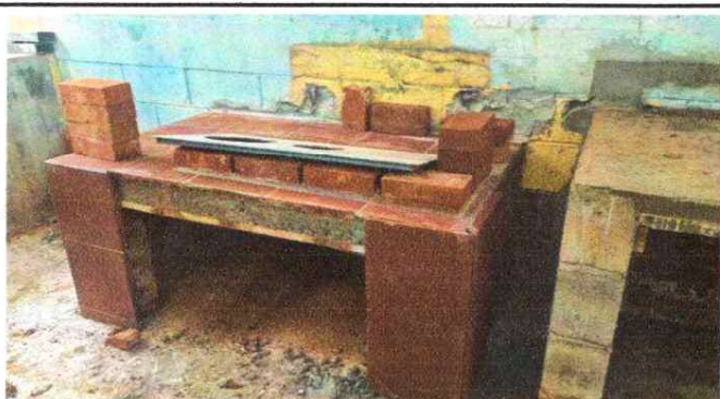
4.1 Sustitución de plancha de metal
