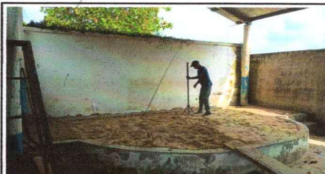
7.1 Reparación de torta de cemento
