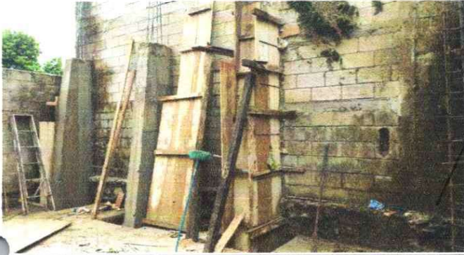
6.1 Reparación de muro
