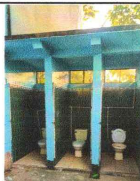
5.1 Sustitución de puerta de metal
