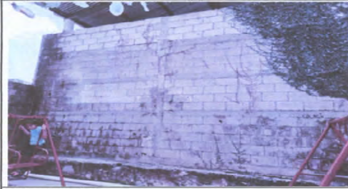
8.1 Reparación de de muro
