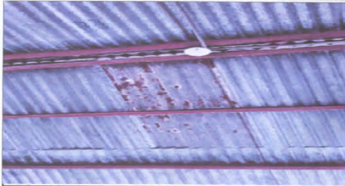
1.1 Sustitución de lámina, por lámina troquelada aluzinc 26
