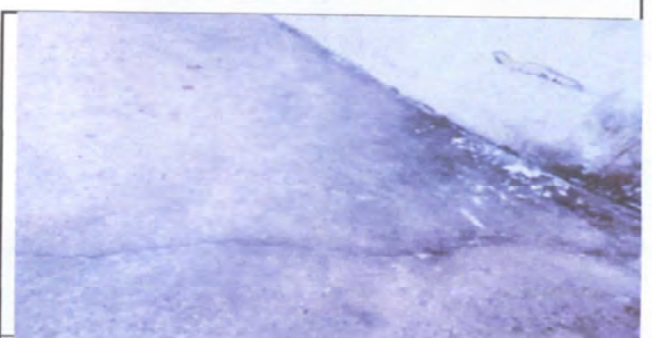
7.1 Reparación de torta de cemento
