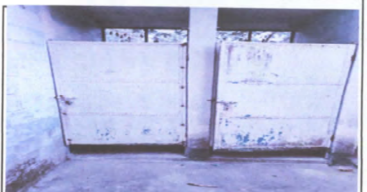
5.1 Sustitucion puerta de metal
