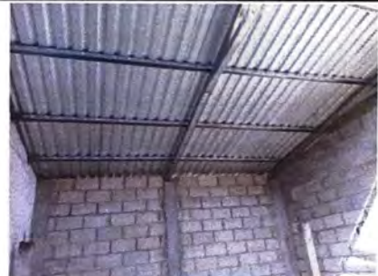
Foto 3: INSTALACION DE LAMINA
