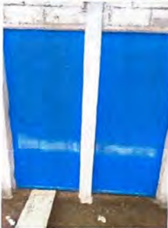
Foto 9: INSTALACION PUERTAS DE METAL
