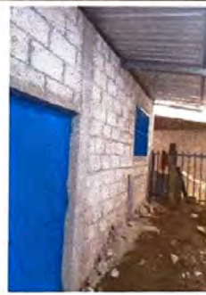
Foto 10: INSTALACION PUERTA DE METAL
