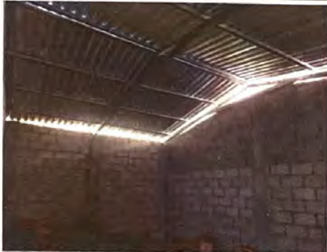
Foto7: INSTALACION DE LAMINA + REMOZAMIENTO DE MURO DE BLOCK
