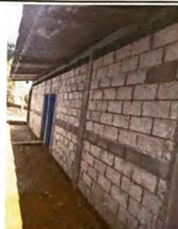
Foto 2: REMOZAMIENTO DE MUROS
