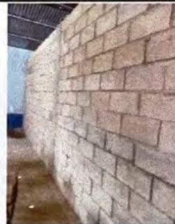
Foto 4: REMOZAMIENTO DE MURO
