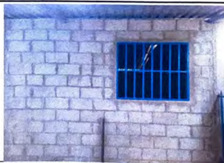
Foto 5: REMOZAMIENTO DE MURO DE BLOCK
