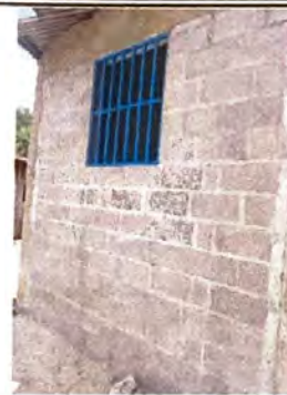
Foto 8: INSTALACION DE BALCON DE METAL
