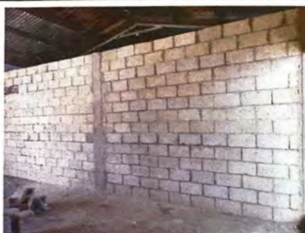
Foto 1: REMOZAMIENTO DE MURO DEVISOR EN AULAS
