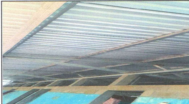
1.2 Sustitución de soporte de madera por metal
