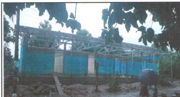
3.1 Sustitución de puertas de aula
