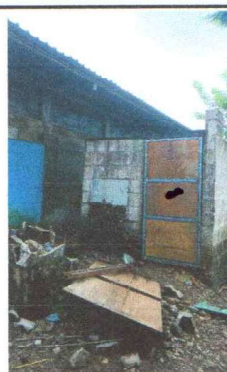
3.2 Sustitución de Puertas en servicios sanitarios
