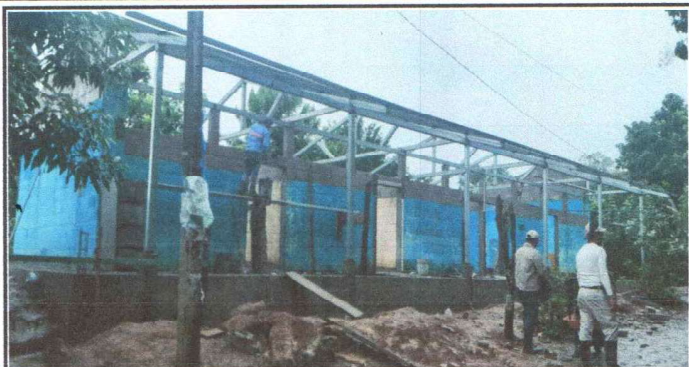
1.1 Sustitución de lámina
