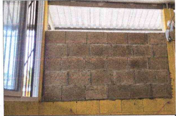
Foto 2: Sustituciones de balcones a block
