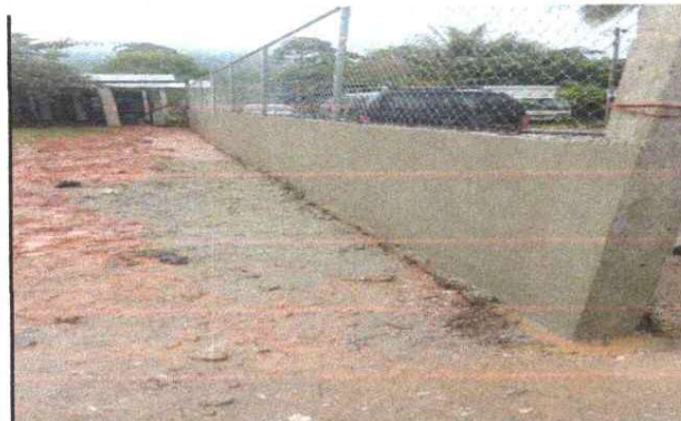
Foto 3: Seguimiento de Muro Perimetral
