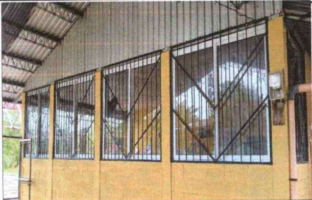
Foto1: Sustitución de ventanas de vidrio
