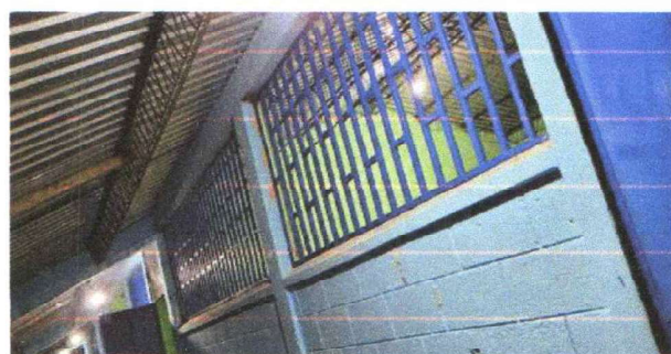
FOTO 14: SUSTITUCIÓN DE BALCONES
