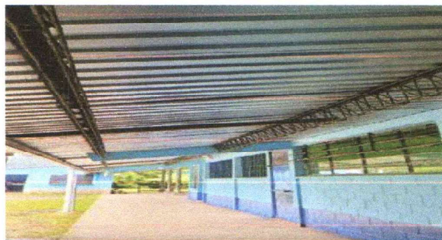
FOTO 12: SUSTITUCIÓN DE COSTANERAS
