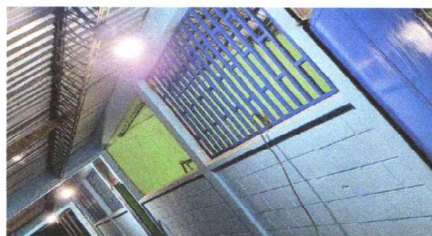
FOTO 9: SUSTITUCION DE BALCONES
