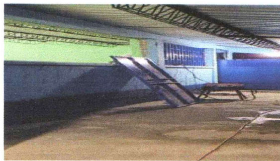
FOTO 7: SUSTITUCION DE COSTANERAS
