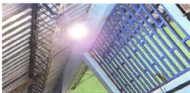
FOTO 10: REPARACIÓN DE CABLEADO ELECTRICO
