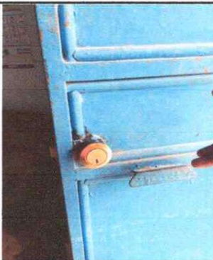
Foto 8. Sustitución de chapa de puerta de la Dirección
