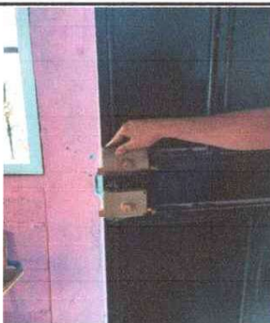
Foto 10. Sustitución de chapa de puerta de la Dirección
