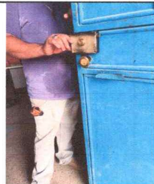
Foto 9. Sustitución de chapa de puerta de la Dirección
