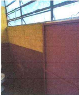
Foto 6: Instalación de la puerta de Baño
