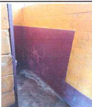
Foto 5: Sustitución de Puerta de Baño
