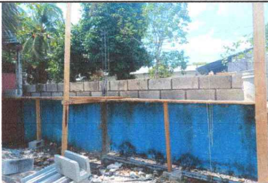
Foto1: Proceso de Culminación de Muro Perimetral.
