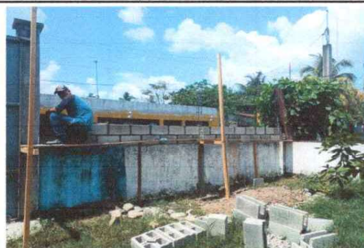
Foto 2: Proceso de Culminación de Muro Perimetral.
