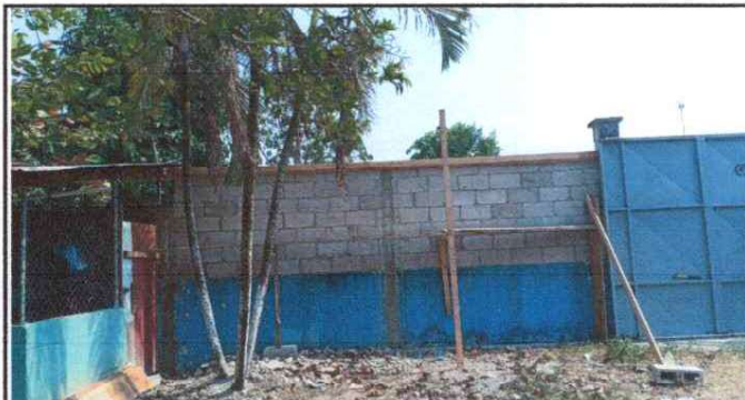
Foto 4: Proceso de Culminación de Muro Perimetral.
