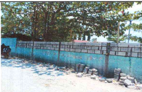
Foto 3: Proceso de Culminación de Muro Perimetral.
