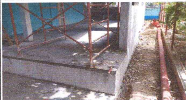
Foto 2: Área de la pila
