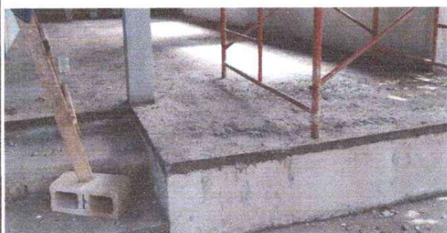
Foto 3: Piso en remoción
