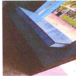
Reparación de Cenefa y azulejo de ventana
