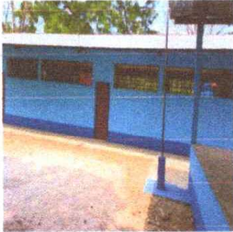
Renglón: Sustitución de pintura general de la escuela ( exterior) 7
