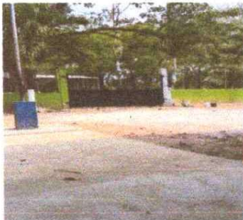
Renglón: Fabricación de portón Principal 9
