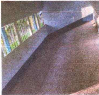
Sustitución de Piso de Cemento 1
