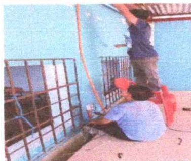
Renglón: Sustitución de cableado eléctrico completo
