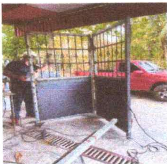
Renglón: Fabricación de portón Principal 9
