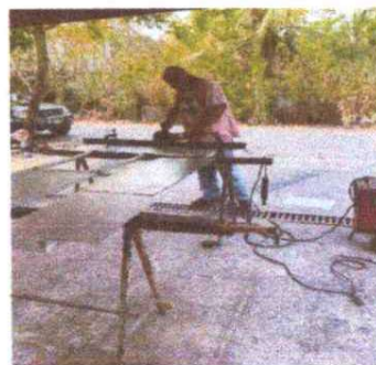
Fabricación de Ventana Metálica de Ventana 4
