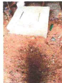
Foto 4: Drenaje de agua residuales finalizado
