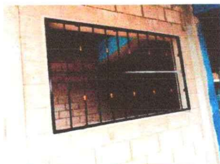
Foto 3: Balcones de cocina instalados
