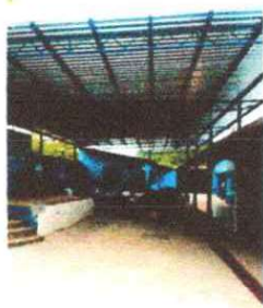
Foto 5: Techado de escenario finalizado
