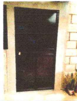
Foto 2: Puerta de cocina instalada
