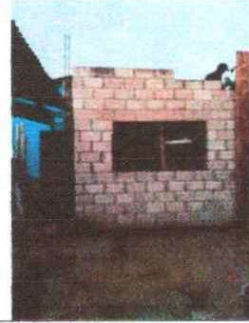
Foto 2: Construcción de paredes de cocina
