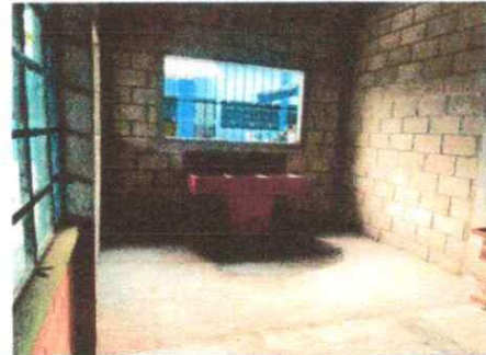
Foto 4: Instalación de ventanas con balcones e instalación de Pila
