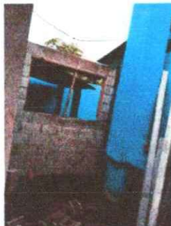
Foto 3: Levantamiento de paredes del área de cocina
