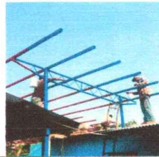
Foto 6: Aplicación de pintura anticorrosiva en costanera para techo
