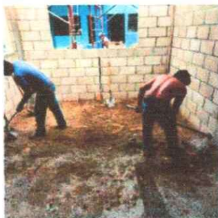
Foto 5: Nivelación para posteriormente fundir piso de concreto en área de cocina
