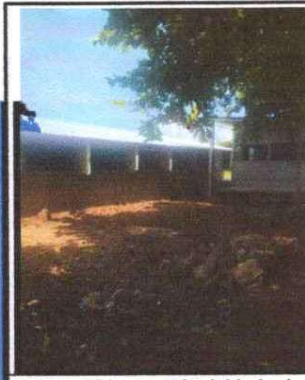
Asi quedó la escuela del lado de atrás donde se hizo la cocina
