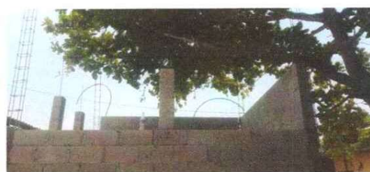
Levantamiento de block de Cocina
