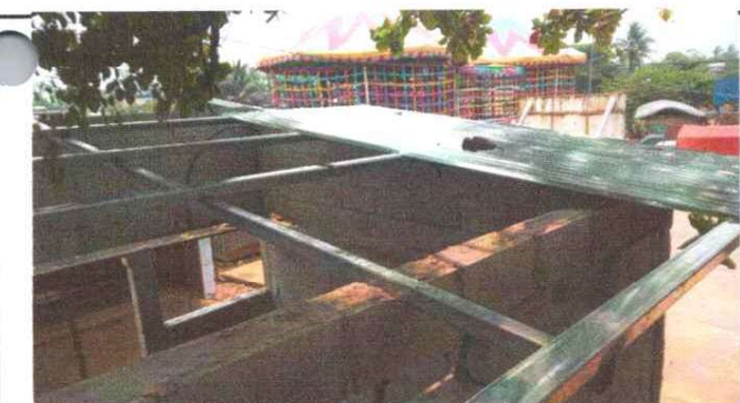
Sustitucion de techo de la escuela e instalación de techo de cocina
