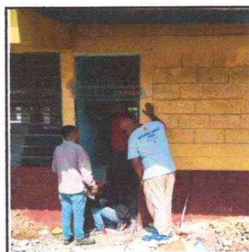
Sustituyendo puertas y chapas
