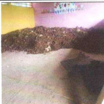
Relleno de piso
