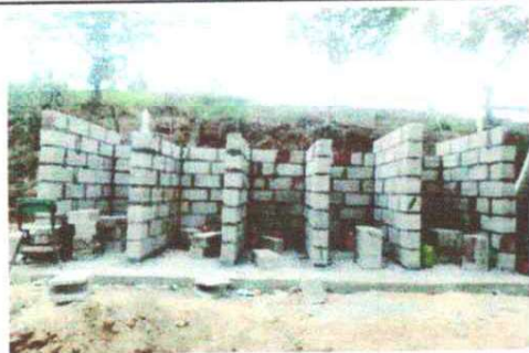
SUSTITUCIÓN DE BAÑO
