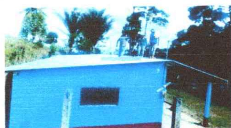
SUSTITUCIÓN DE TECHADO
