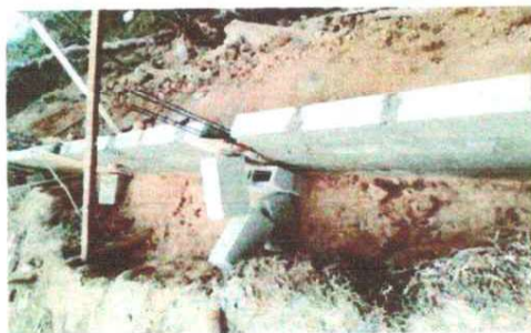
REPARACIÓN DE MURO PERIMETRAL
