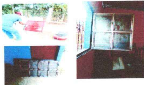
COLOCACIÓN DE VENTANAL
