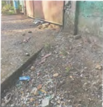
FOTO 7: Reparación de planchas de concreto de patio
