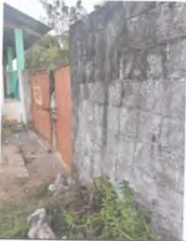
FOTO 5: Sustitución de portón de metal
