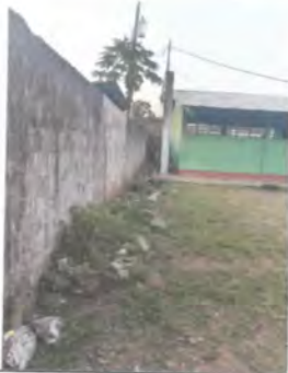
FOTO 6: Pintura en muros exteriores e interiores
