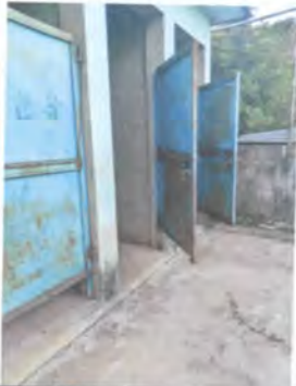
FOTO 4: Sustitución de puerta en servicios sanitarios
