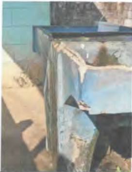
FOTO 9: Sustitución de pila de cemento de dos lavadores
