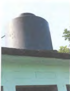
FOTO 8: Sustitución de depósito de agua 1100 Lt
