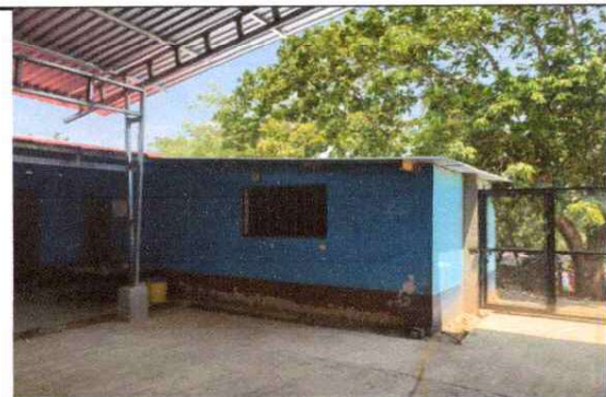
sustitucion e instalacion de lamina.
