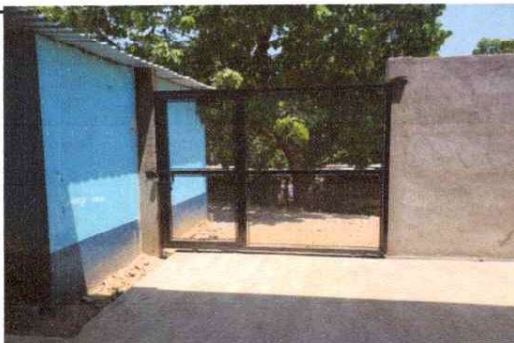
sustitucion de porton de metal
