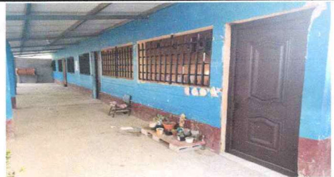
mantenimiento a balcones de metal
