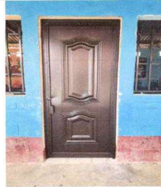
sustitucion de puertas de metal
