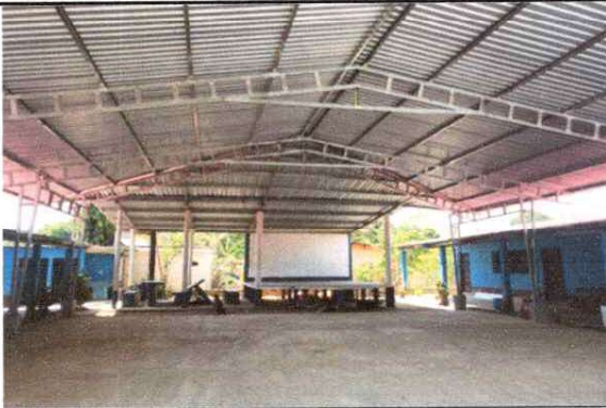
sustitucion de lamina con estructura de metal
