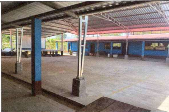
foto 3 Sustitución de estructura de soporte de metal, por metal
