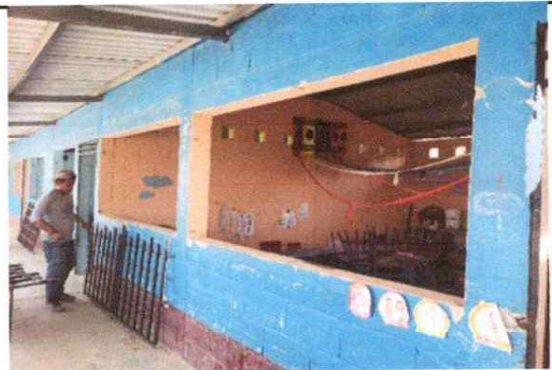
mantenimiento a balcones y puertas de metal
