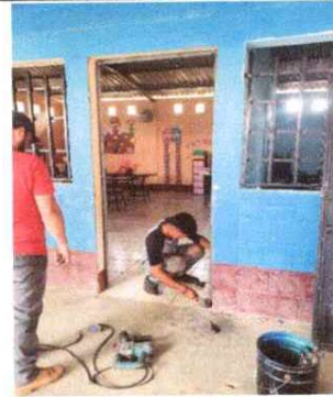
sussssssssssttustitucion de puertas de metal
