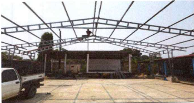
sustitucion e instalacion de lamina con estructura de metal
