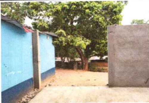
sustitucion de porton
