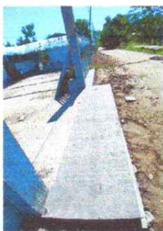
Foto 5: Mantenimiento de Torta de concreto
