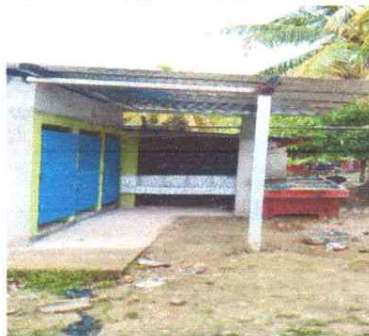
Foto 4: Mantenimiento de puertas de Baño y sustitución de azulejo en migitorio
