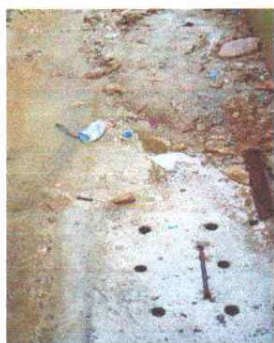
Foto 3: Mantenimiento de Caja de registro
