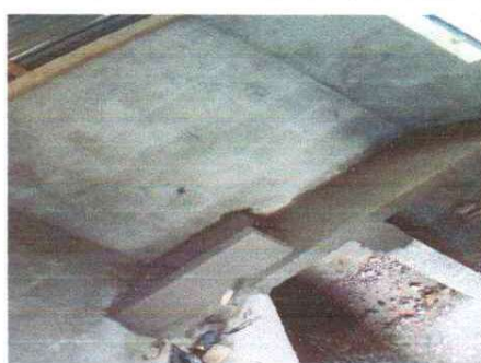
Foto 6: Mantenimiento de cocina
