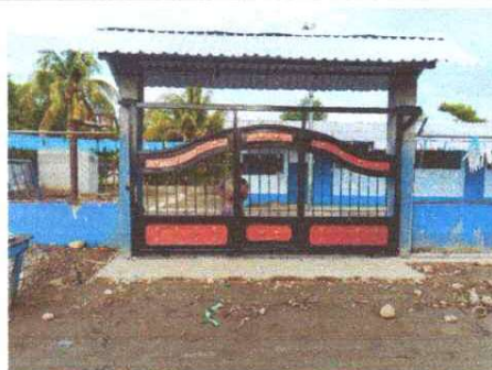
Foto 2: Sustitución de Porton
