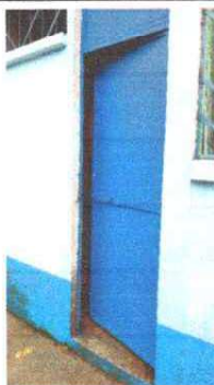
Foto 1: Mantenimiento de puerta de bodega
