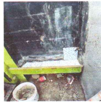
Foto 2: Mantenimiento de migitorio, azulejo nuevo
