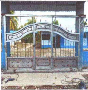
Foto 1: Sustrucion de Porton
