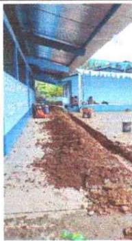
Foto 3: Mantenimiento de agua fluviales
