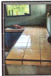
SUSTITUCIÓN DE PISO RUSTICO, CERÁMICA Y MEZON EN COCINA
