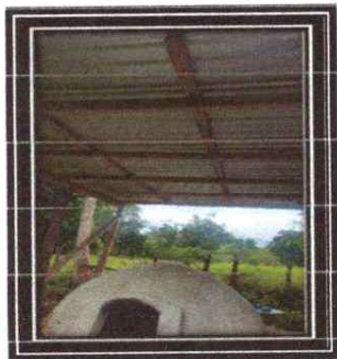
SUSTITUCIÓN DE LÁMINA POR LÁMINA TROQUELADA EN COCINA
