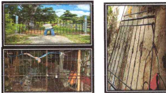
SUSTITUCIÓN DE PORTÓN ENTRADA PRINCIPAL
