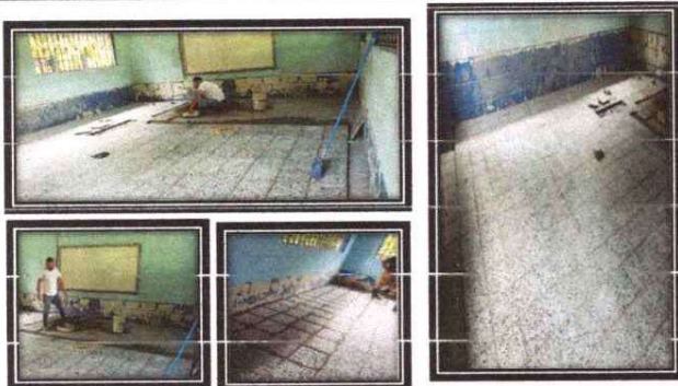
SUSTITUCIÓN DE PISO POR PISO GRANITO
