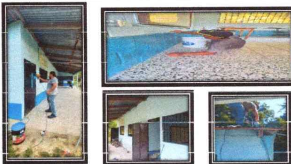
PINTURA EN MUROS INTERIORES, EXTERIORES Y LÁMINA
