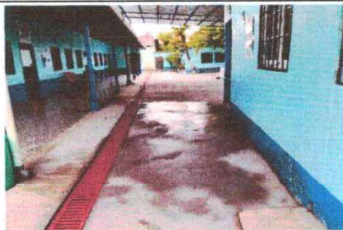
Foto 3: Instalación de rejilla
