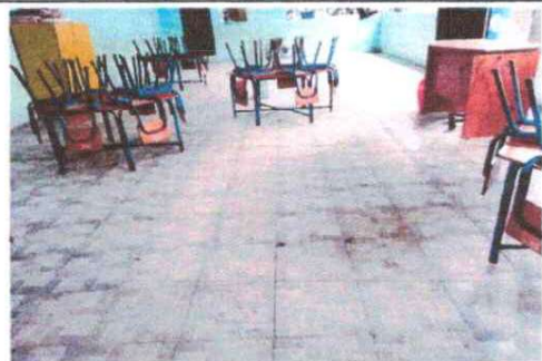
Foto 2: instalación terminada de piso cerámico en aulas
