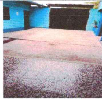
Foto 4: Rampa de entrada de escuela terminada
