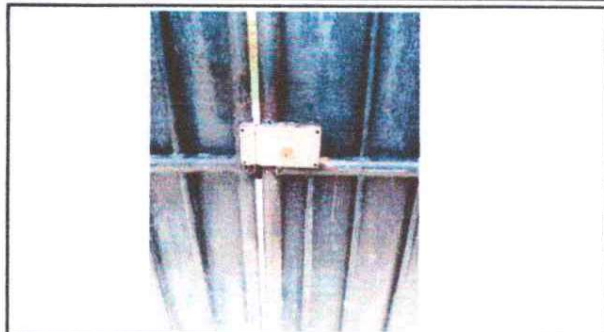
Foto 2: Cambio de chapa en porton principal
