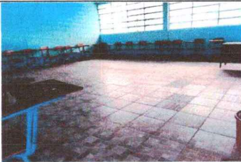
Foto 1: instalación terminada de piso cerámico en aulas
