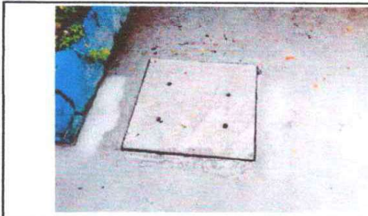
Foto 6: segunda caja de desagüe de aguas pluviales
