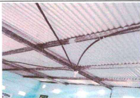
Foto 5: Cambio de cableado eléctrico terminado
