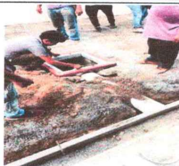
Foto 2: Instalación de drenaje de aguas pluviales
