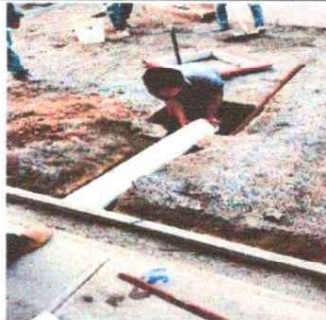
Foto 3: Instalación de tubo de drenaje para aguas pluviales
