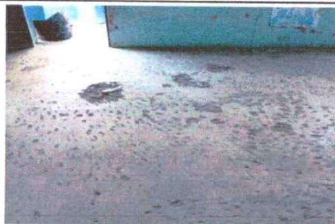
Foto 3: Reparación de piso de aulas
