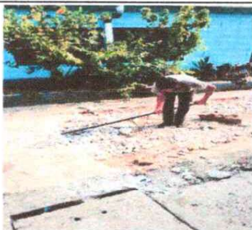
Foto 3: Preparación previa para plancha de concreto
