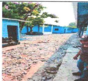
Foto 4: Preparación previa para plancha de concreto
