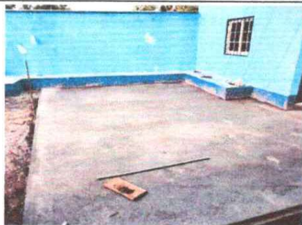
Foto 1: Parte terminada de plancha de concreto
