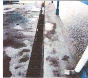
Foto 2: Zanjeado para instalación de rejilla de aguas pluviales
