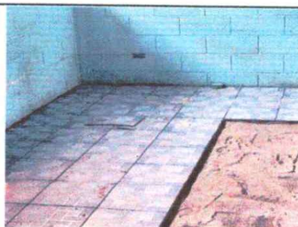
Foto 4: Colocación de piso cerámico en aulas
