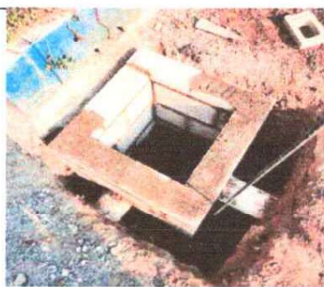
Foto 5: Instalación de segunda caja de drenaje de aguas pluviales
