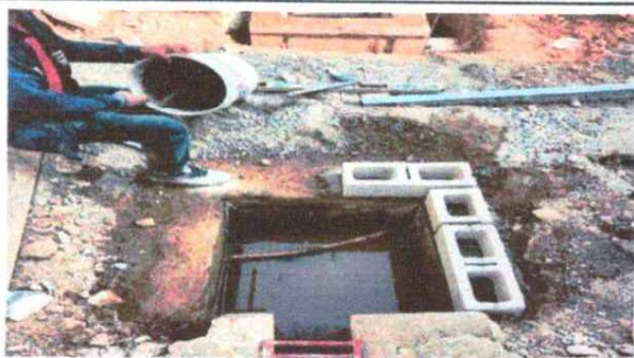
Foto 1: Caja de drenaje de aguas pluviales
