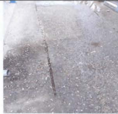
FOTO 8. Reparación de planchas de concreto de patio.
