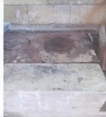
FOTO 14. Sustitución de plancha de metal de 3 hornillas
