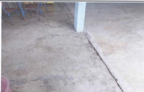
FOTO 3. Sustitución de piso de torta de concreto
