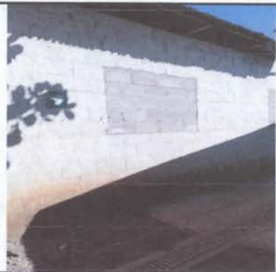
FOTO 16. Aplicación de repello de muro de contención.
