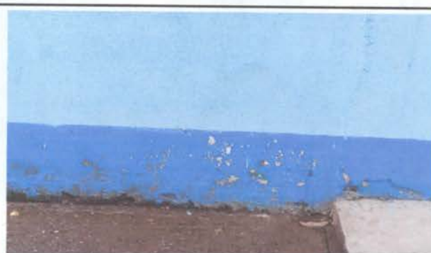
FOTO 6. Pintura en muros externos e interiores
