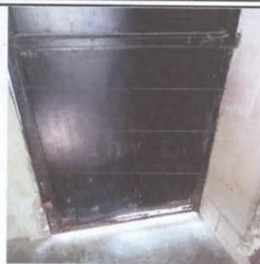
FOTO 2. Sustitución de puerta
