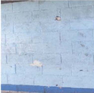
FOTO 7. Pintura en muros exteriores e interiores
