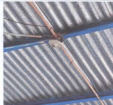
FOTO 12. Reparación de cableado eléctrico. Sustitución de ducto eléctrico mas accesorios.
