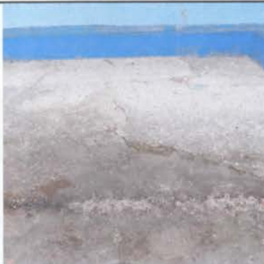
FOTO 9. Reparación de planchas de concreto de patio.
