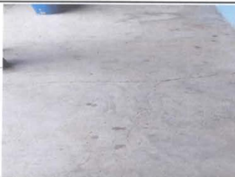
FOTO 5. sustitución de piso de torta de concreto
