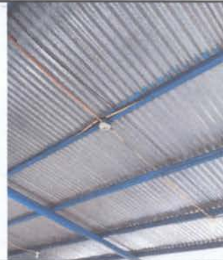
FOTO 10. Sustitución de focos ahorradores
