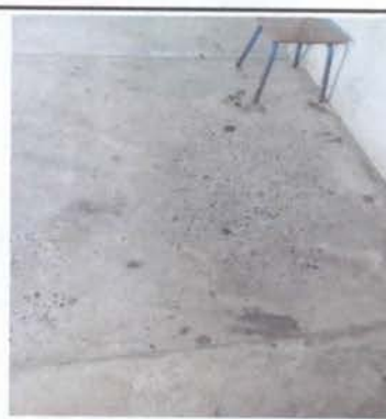
FOTO 4. Sustitución de piso de torta de concreto
