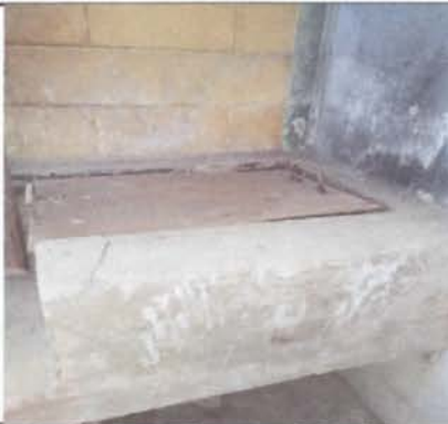
FOTO 15. Instalación de azulejo en estufa rural.
