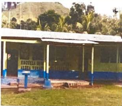
Foto 7: ESTRUCTURA DE BASES DE CONCRETO
