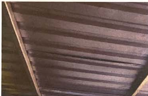
Foto 9: INSTALACION DE LAMINA
