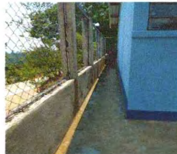
reparación de muro perimetral
