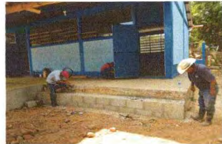
Sellado de grietas y fisuras en muros
