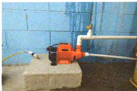
Sustitución de bomba de agua
