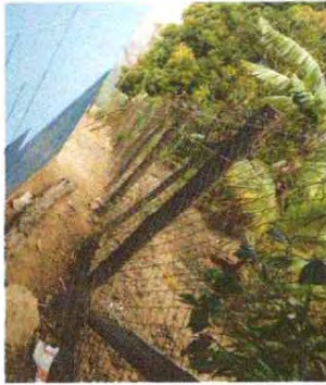
reparacion de cerco de puas
