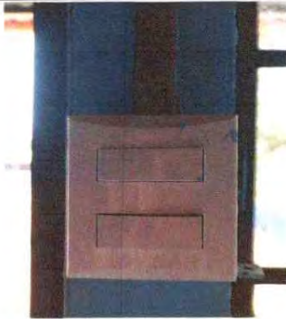
Sustitución Interruptores Simples
