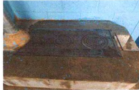
Sustitución de plancha de metal
