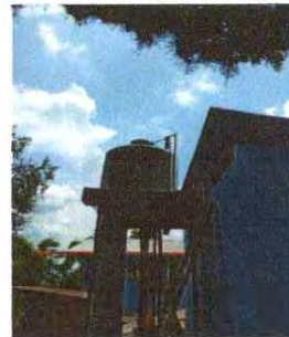
Sustitución de deposito de agua 2500 litros
