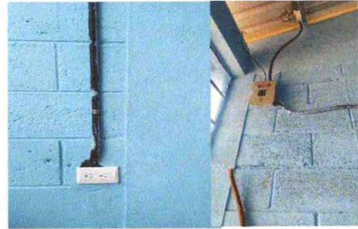
Sustitución de tomacorriente dobles, Sustitución de Flipones
