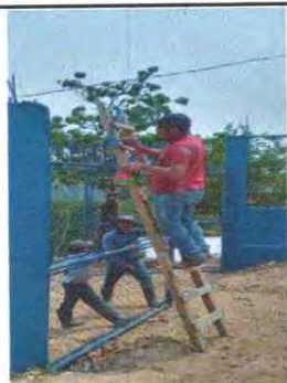
Mantenimiento a portones de metal
