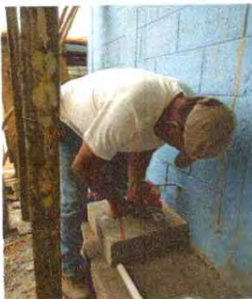
Sustitución de bomba de agua
