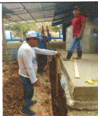
Sellado de grietas y fisuras en muros
