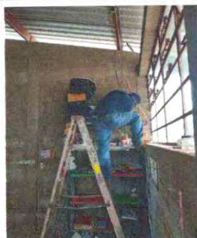
Sustitución de focos ahorradores
