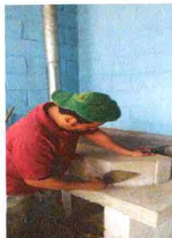
Sustitución de plancha de metal
