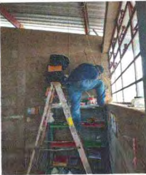
Reparación de cableado electrico. Sustitución de ducto eléctrico mas accesorios.
