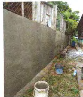
reparación de muro perimetral
