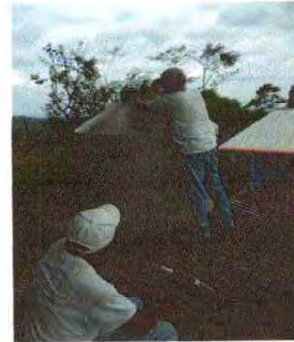
Sustitución de deposito de agua 2500 litros
