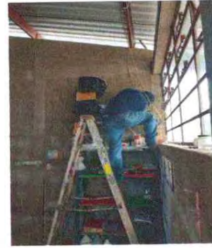
Sustitución de tomacorriente dobles, Sustitución de Flipones
