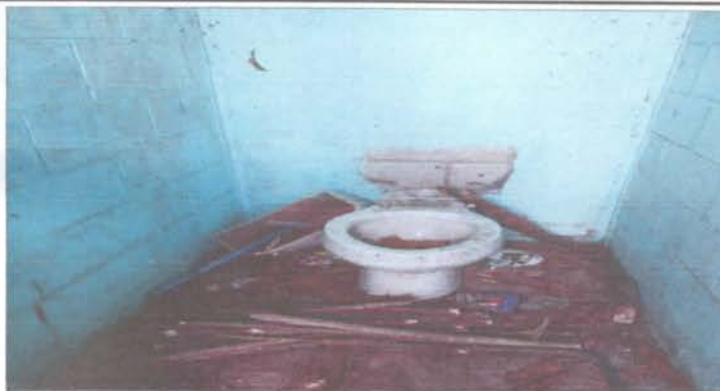
Sustitución de accesorios inodoros contra llave, tubo de abasto. Sustitución de tapadera sanitario. Sustitución inodoro
