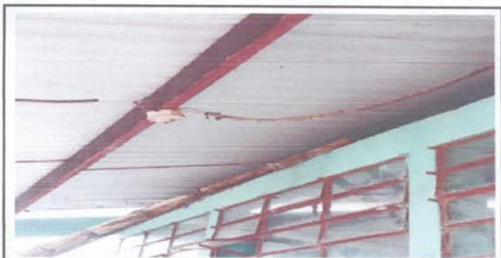
Sustitución de plafonera
