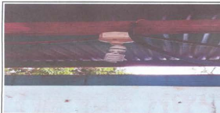
Sustitución de focos ahorradores
