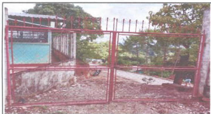
Mantenimiento a portones de metal
