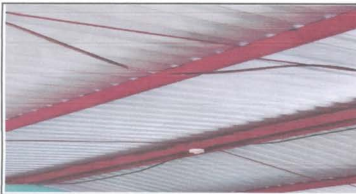
Reparación de cableado eléctrico. Sustitución de ducto eléctrico mas accesorios.
