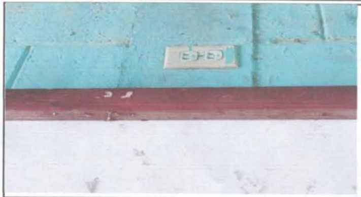
Sustitución de tomacorriente dobles, Sustitución de Flípones
