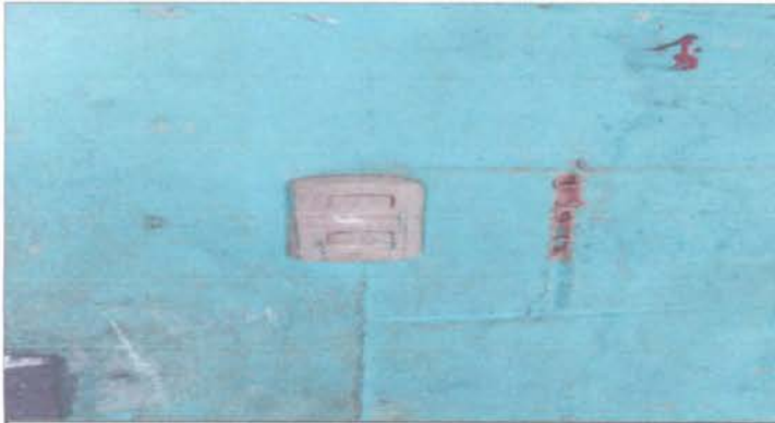
Sustitución Interruptores Simples
