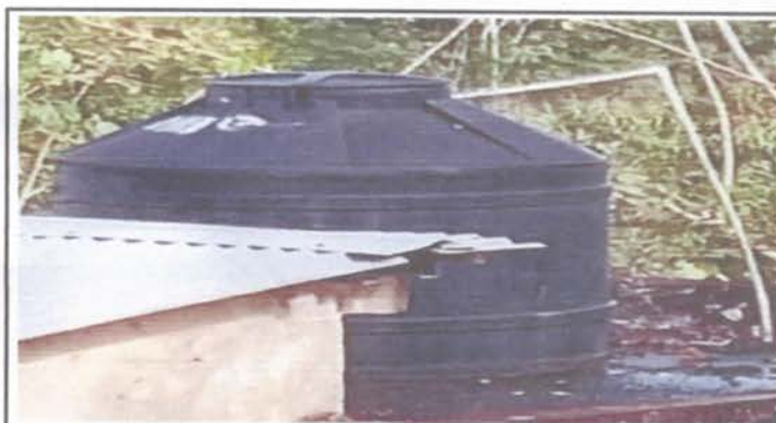
Sustitución de deposito de agua 1000 litros
