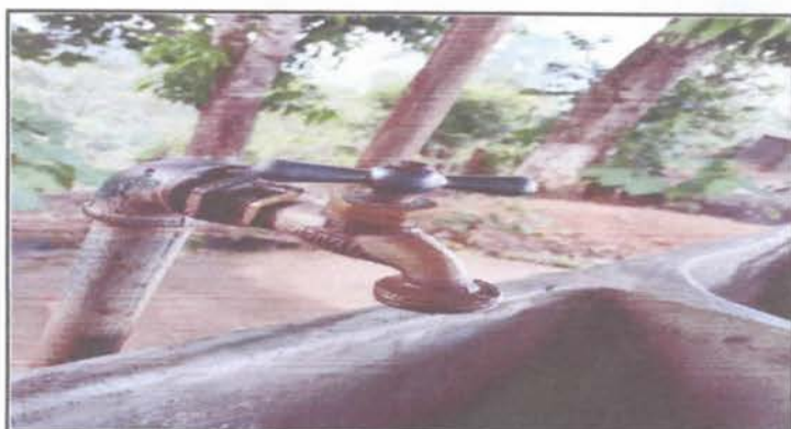
Sustitución de llave de chorro
