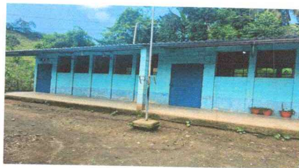
FOTO 2: SUSTITUCIÓN DE PUERTAS
