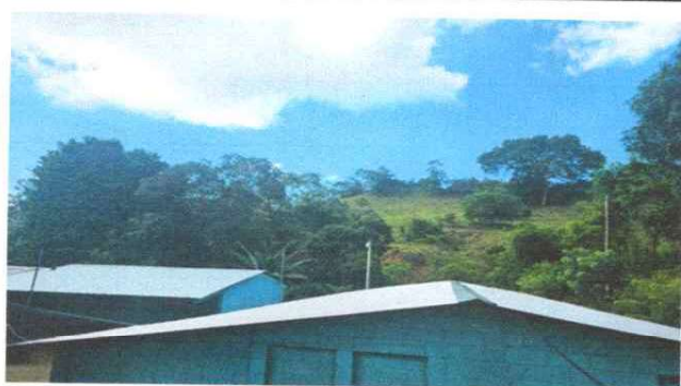
Foto 3: SUSTITUCIÓN DE LAMINA
