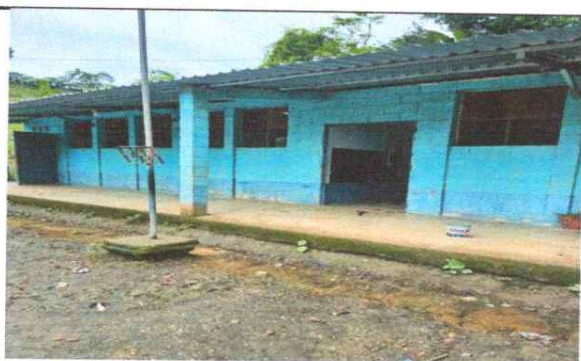
Foto 3: SUSTITUCIÓN DE PUERTAS
