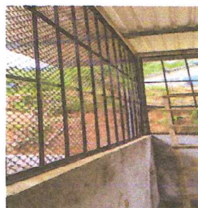
4. VENTANAS. SUSTITUCION DE BALCONES DE METAL CON MALLA GALVANIZADA
