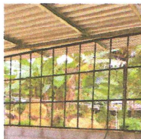
2. SUSTITUCION DE ESTRUCTURA DE SOPORTE DE MADERA POR METAL, 27 M2
