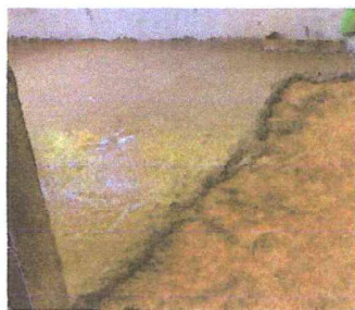
5. SUSTITUCION DE PISO DE TORTA DE CONCRETO
