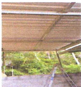
1. SUSTITUCION DE LAMINA TROQUELADA ALUZING CAL. 26 27M2
