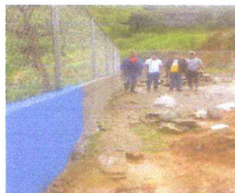
6. REPARACION DE MURO PERIMETRAL DE BLOCK CON TUBO HG Y MALLA GALVANIZADA, SOLERAS INTERMEDIAS Y COLUMNAS
