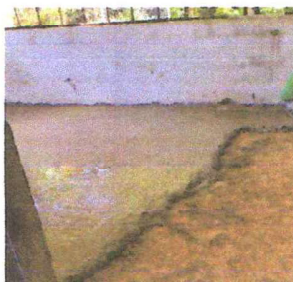
Foto 5: SUSTITUCION DE PISO DE TORTA DE CONCRETO
