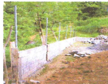
Foto 6: REPARACION DE MURO PERIMETRAL DE BLOCK CON TUBO HG MALLA GALVANIZADA, SOLERAS INTERMEDIAS Y COLUMNAS
