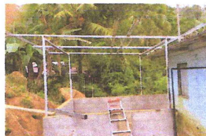
Foto 4: SUSTITUCION DE ESTRUCTURA DE SOPORTE DE MADERA POR METAL
