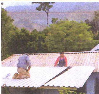
Foto 1: SUSTITUCION DE LAMINA TROQUELADA POR ALUZING CAL 26
