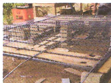
Foto 2: SUSTITUCION DE BALCONES DE METAL CON MALLA GLAVANIZADA
