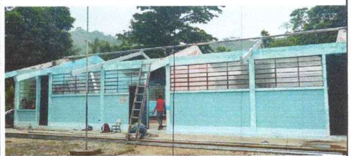
Foto 2: SUSTITUCIÓN DE ESTRUCTURA METALICA
