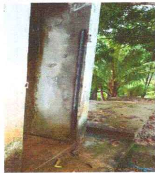
Foto 3: SUSTITUCIÓN DE PUERTAS DE SERVICIO SANITARIO
