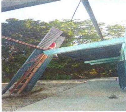
Foto1: SUSTITUCIÓN DE LÁMINA Y ESTRUCTURA METALICA
