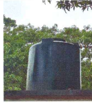
Foto 4: SUSTITUCION DE ACCESORIOS DE DEPOSITO DE AGUA
