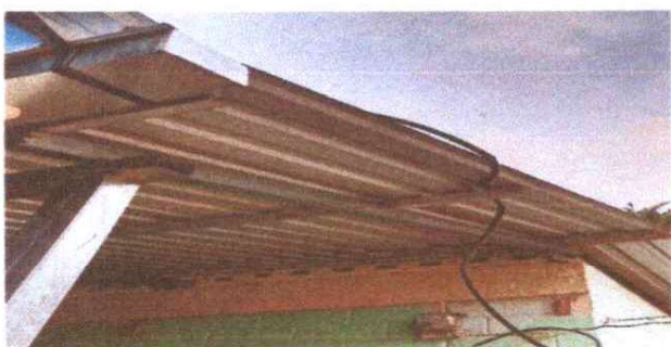
Foto 5: Sustitución de estructura de madera por metal.
