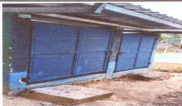
Foto 4: Sustitución de puertas de metal.
