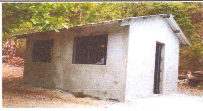
Foto 1: Reparación de cocina, estructura del techo.
