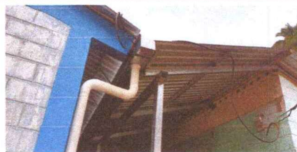
Foto 6: Elevación de estructura para unir laminaas de ambos lados.
