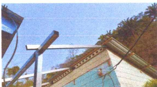
Foto 5: Sustitución de estructura de madera por metal.
