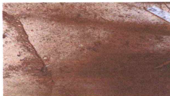
Foto 2 Reparación de piso de cocina por una nueva torta de concreto.
