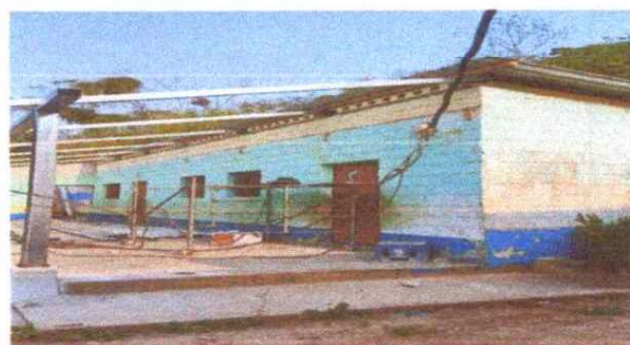
Foto 6 Elevación de estructura para unir laminas de ambos lados.
