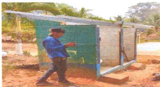
Foto 3 Cambio de estructura de madera por metal y lámina. También 2 puertas nuevas y un servicio sanitario.
