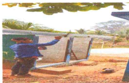
Foto 4: Sustitución de puertas de metal.
