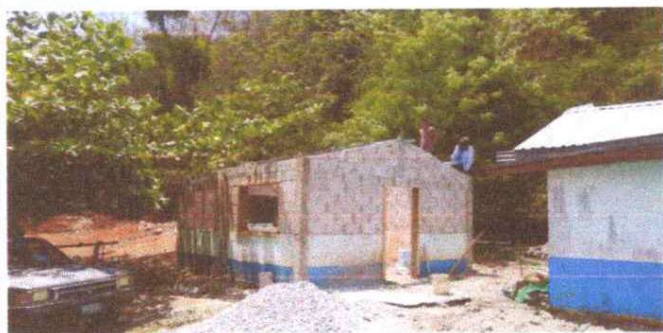
Foto 1 Reparación de cocina, estructura de techo y laminas. También 3 balcones y una puerta nueva.
