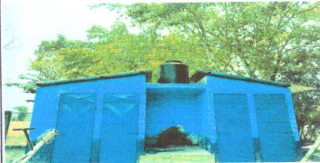
SUSTITUCION DE INODOROS - LIMPIEZA DE FOSA SEPTICA - SUSTITUCION DE DEPOSITO DE AGUA 1700 LT. - SUSTITUCION DE BOMBA DE AGUA
