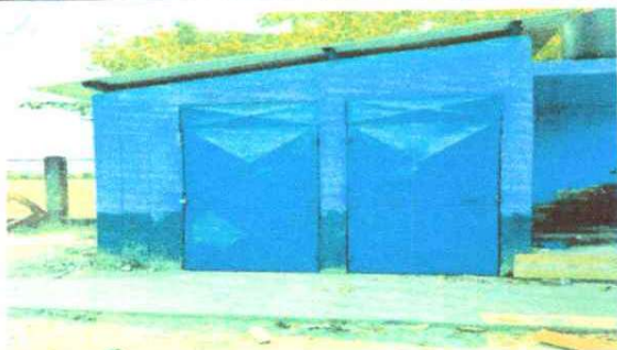
SUSTITUCION DE PUERTAS EN SERVICIOS SANITARIOS - SUSTITUCION DE LAMINA, POR LAMINA TROQUELADA ALUZINC CALIBRE 26
