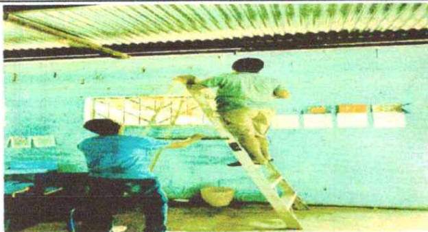
SUSTITUCION DE FOCOS AHORRADORES - SUSTITUCION DE DUCTO ELECTRICO MAS ACCESORIOS
