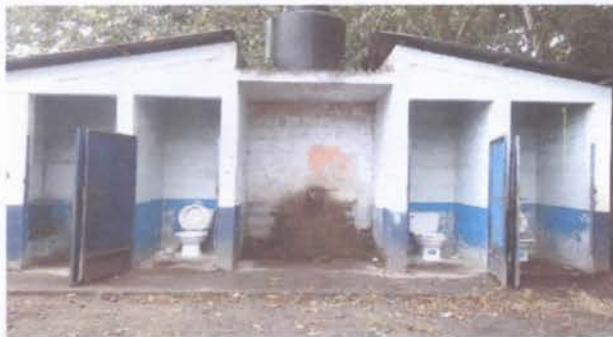
SUSTITUCION DE PUERTAS EN SERVICIOS SANITARIOS - SUSTITUCION DE LAMINA, POR LAMINA TROQUELADA ALUZINC CALIBRE 26
