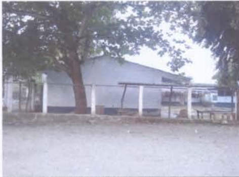
REPARACION DE MURO PERIMETRAL DE BLOCK
