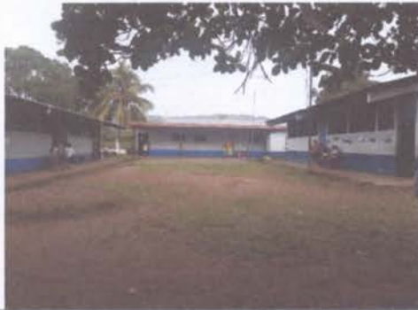
SUSTITUCION DE PUERTAS EN AULAS
