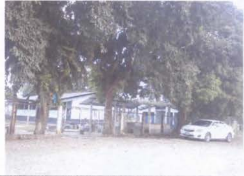
REPARACION E MURO PERIMETRAL DE BLOCK
