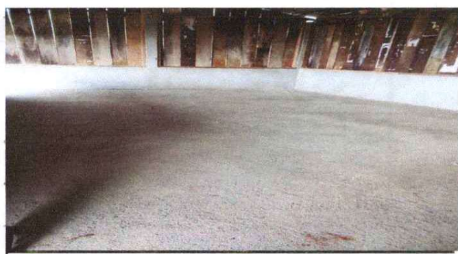
Foto 4: sustitucion de torta de cemento
