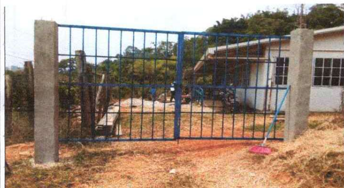
Foto 3: sustitucion de porton de metal
