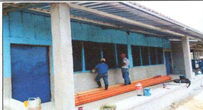
Foto1: Sustitucion de lamina troquelada aluzinc calibre 26
