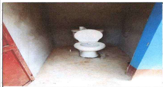
Foto 5: sustitucion de inodoro
