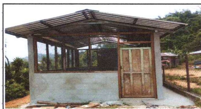
Foto 6: reparacion de cocina
