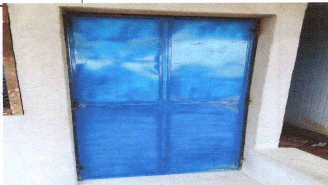
Foto 2: sustitucion de puertas
