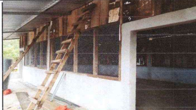
Foto 2: sustrucion de puertas
