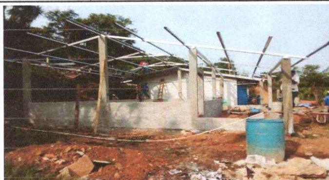
Foto 1: Sustrucion de lamina troquelada aluzinc calibre 26
