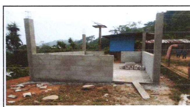
Foto 6: reparacion de cocina
