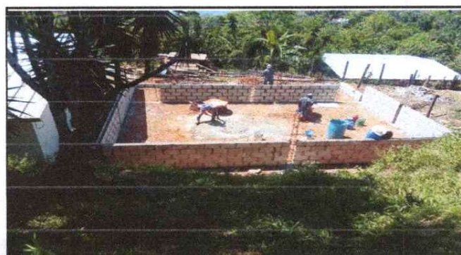
Foto 4: sustrucion de torta de cemento
