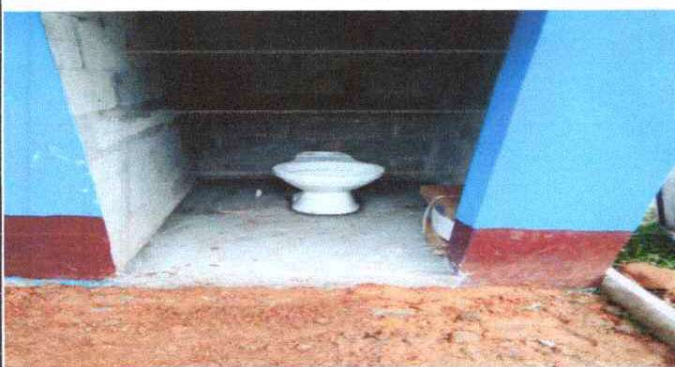
Foto 5: sustrucion de inodoro
